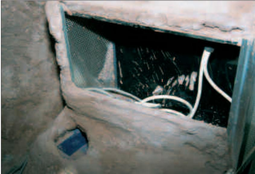
Über dem Schlupfkasten befindet sich ein verschließbarer Kasten, in den über Kabelkanäle mehrere Elektrokabel führen. Von hier aus werden die Heizkabel und die Beleuchtung mit Strom versorgt.
