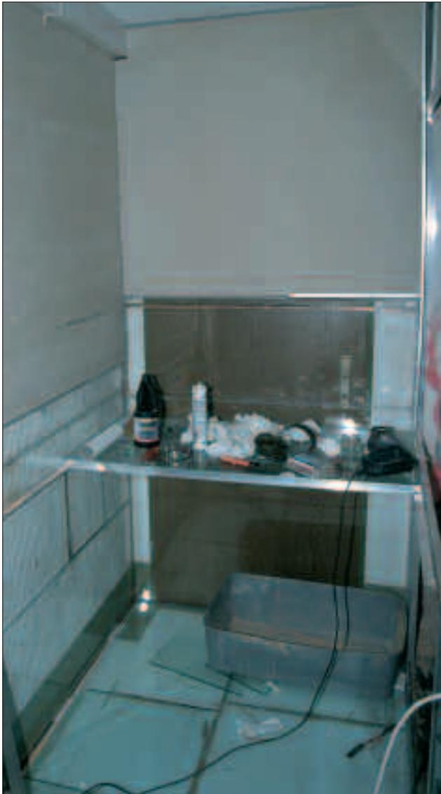
streifen mit Silikon wasserdicht eingeklebt. Auf diese Stege wurden Gipsplatten montiert, die bis zur Decke des Raumes reichen. Zusammen mit den Glasstegen bilden die Gipsplatten die linke Seiten- sowie die Rückwand des Terrariums. Die Gipsplatten wurden untereinander mit Aluminium-L-Profilen verbunden. Auf die Gipsplatten klebte ich dann 90 cm hohe Naturkorkplatten. Im unteren Bereich der Rückwand und der linken Seitenwand wurden aus eingefärbtem Beton künstliche Felsen gebaut.
