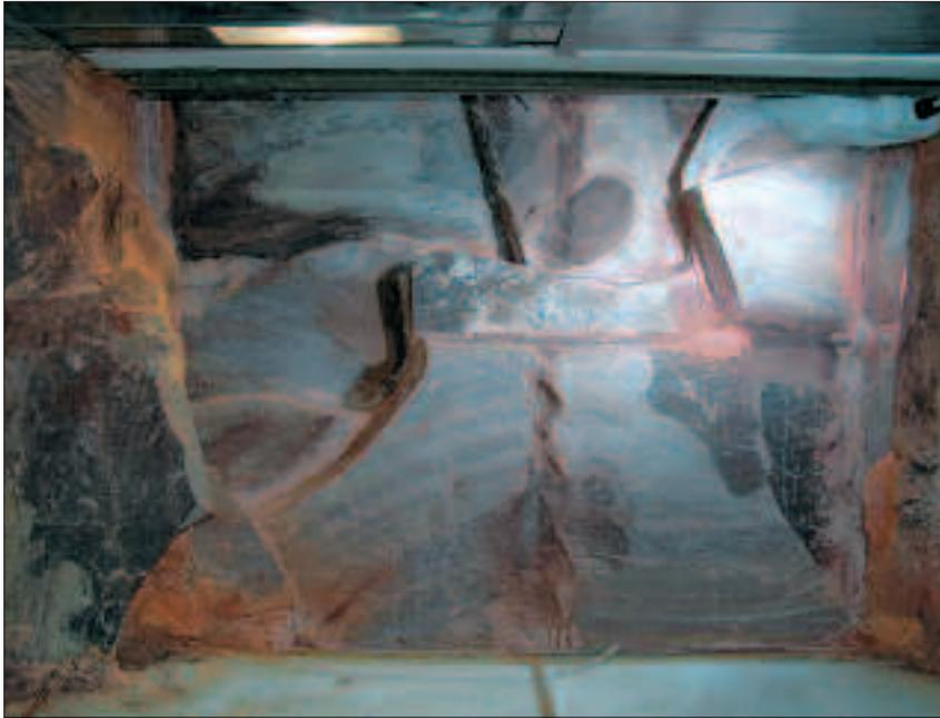
Fertige Felsaufbauten im Kellerschacht. Die Spalten zwischen den Sandsteinplatten wurden mit farblich abgestimmtem Beton verfugt.
