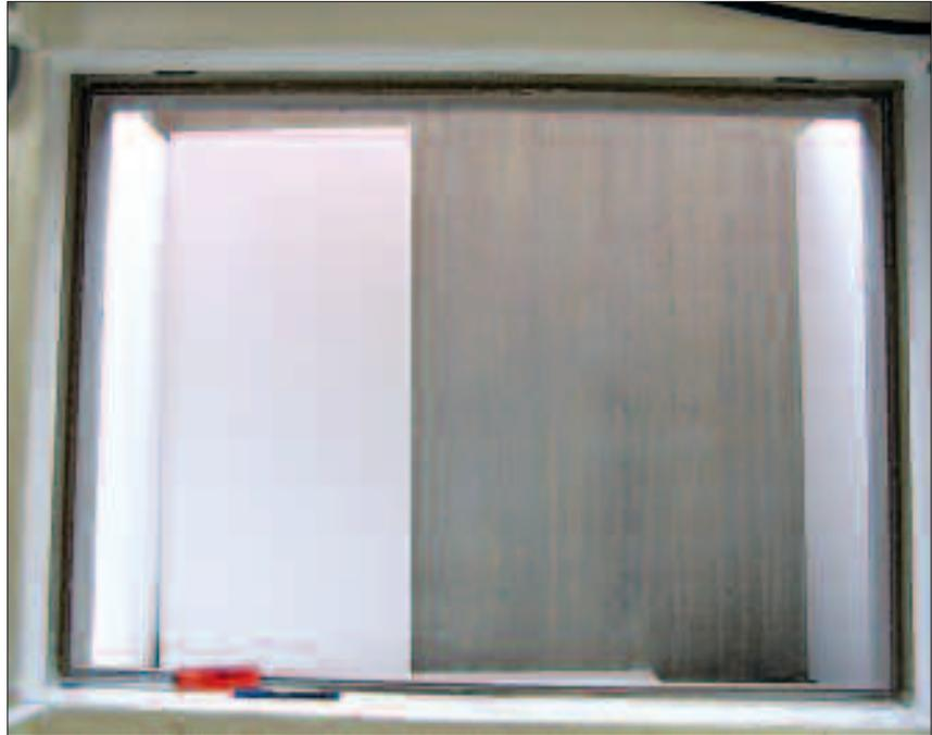
Styroporplatten an den Wänden des Kellerschachtes sollen übermäßige Wärmeverluste verhindern.
