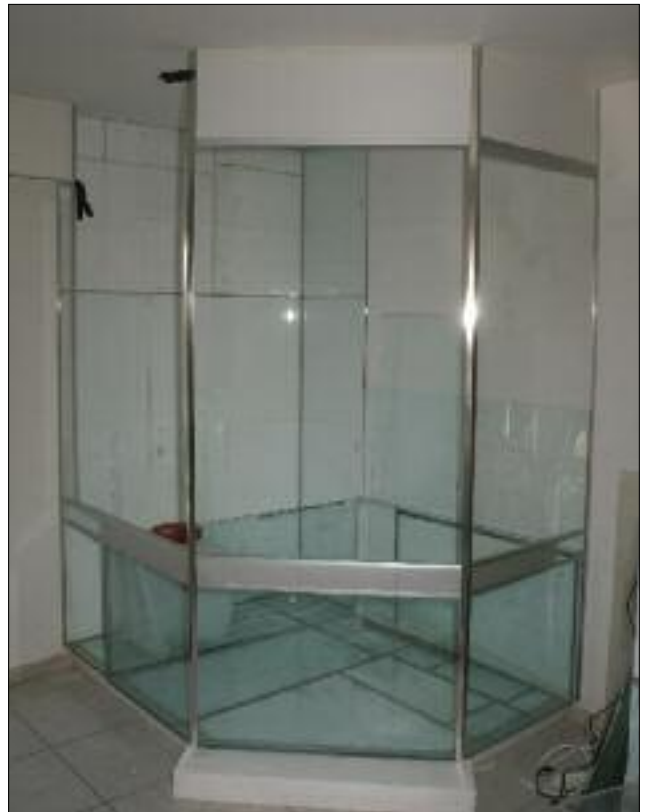
Die Größe und Form des Aquaterriums ist bereits erkennbar. Entlang der Aquarienscheiben wurden Lochbleche eingeklebt. 135°-Aluminiumwinkel bilden die beiden vorderen Kanten.
