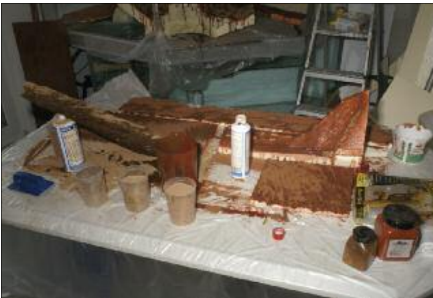
Bei der Verarbeitung von Epoxyd- und Polyurethanharzen, wie sie für die Herstellung der Rück- und Seitenwände verwendet wurden, ist es wichtig, dass man den gesamten Arbeitsbereich großräumig und sorgfältig mit Folien abdeckt
