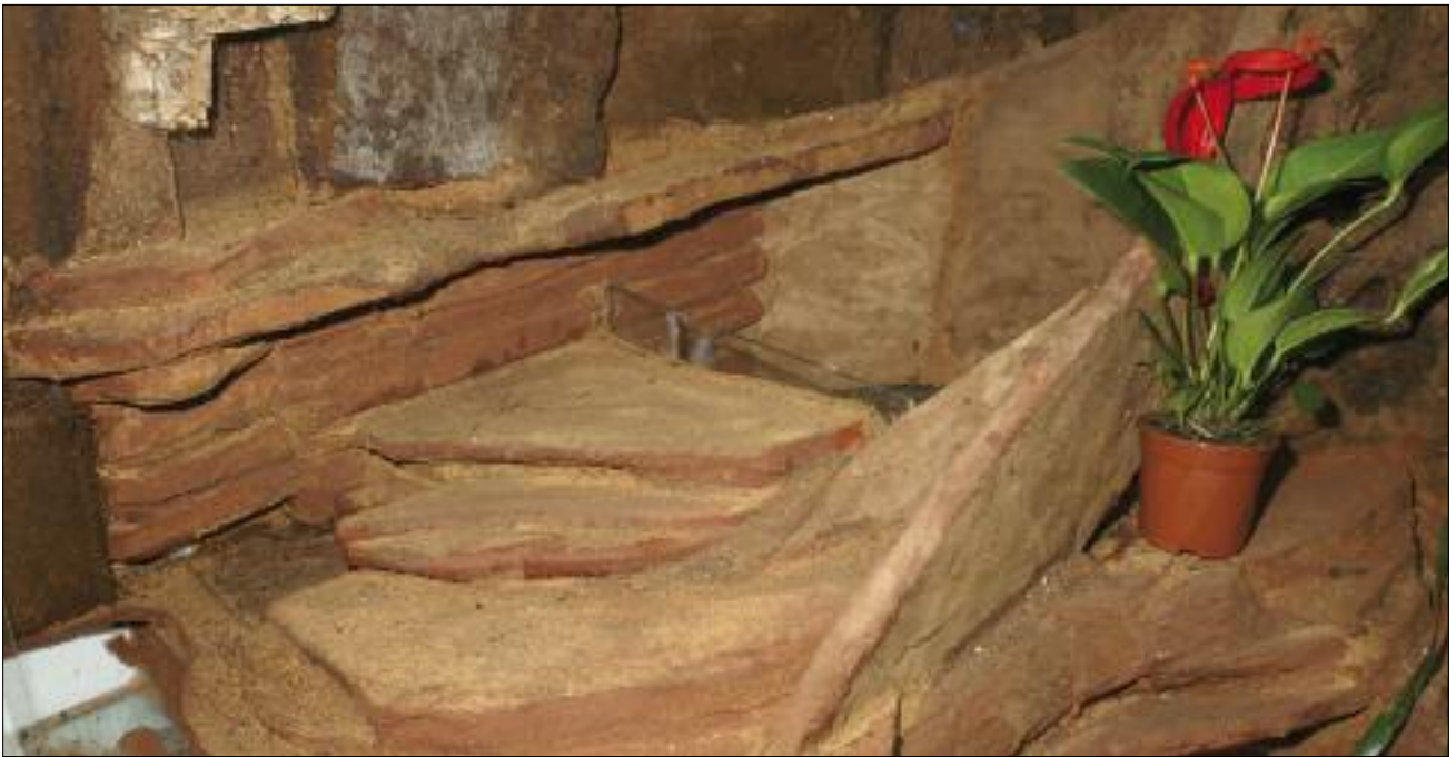
Aus schräg aufeinandergeklebten PU-Hartschaumplatten wurde eine künstliche Felslandschaft mit integriertem Bauchlauf geschaffen. Beschichtet wurden die Platten mit rotbraun eingefärbtem Epoxydharz, das mit Sand und feinem Kies in unterschiedlichen Rot- und Brauntönen beflockt wurde.
