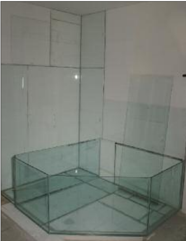
Zunächst wurden 12 mm dicke Glasscheiben auf einem Sockel zu einem Fünfeckaquarium verklebt. Weitere Glasscheiben bildeten die Rückwand des Landteiles.
