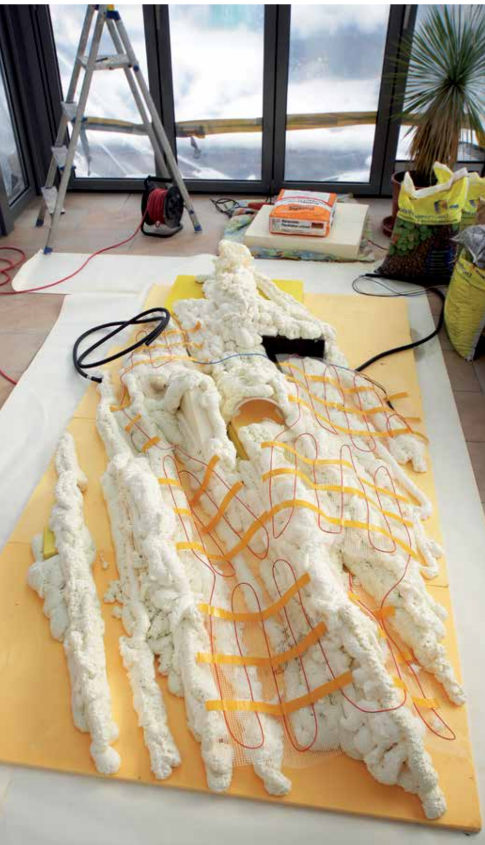
Auf einem Teil der künstlichen Felswandfläche wurde ein thermostat-gesteuertes Heizkabel einbetoniert. Dieses sorgt für milde Wärme und verhindert, dass es im Felsenleguatterrarium allzu kalt wird, wenn die Temperatur im Wintergarten in der kalten Jahreszeit auf Werte unter 10 °C absinkt.
