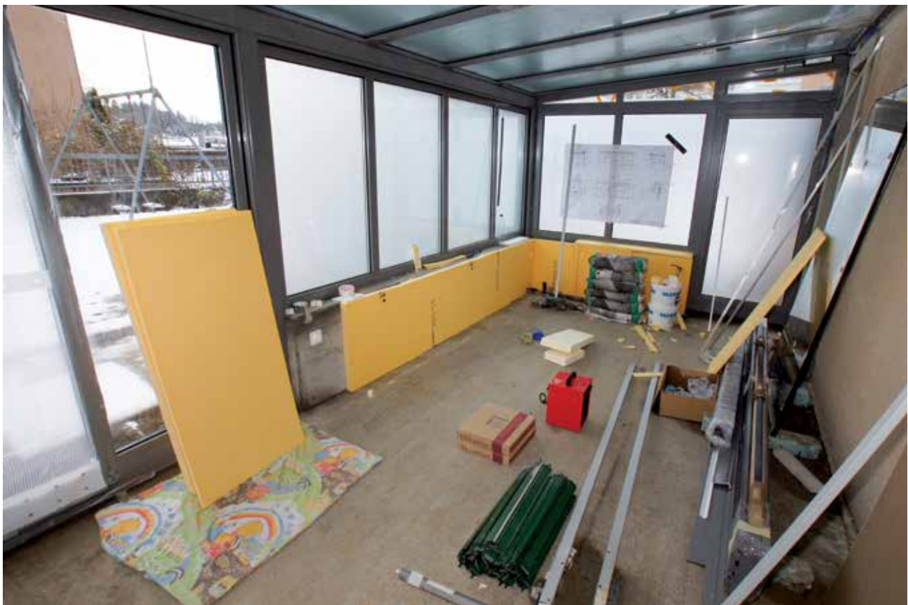
Wärmedämmplatten sollen verhindern, dass über die betonierte Außenmauer des später an dieser Stelle errichteten Hochbeetes allzu viel Wärme verloren geht
