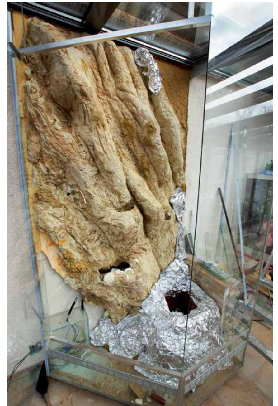
Große Stücke zerknitterter Aluminium-Grillfolie, in den frischen Mörtel gedrückt und nach ein paar Stunden wieder abgezogen, verleihen der Oberfläche der künstlichen Felswand eine naturnahe Struktur
