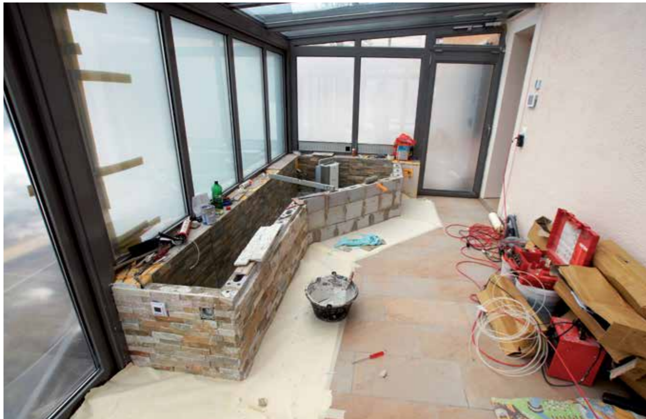
Hochbeet während der Bauphase. Die Umrandung wurde aus Betonformsteinen gemauert. Die darauf geklebten Quarzit-Riegel erzeugen die Illusion einer Natursteinmauer.
