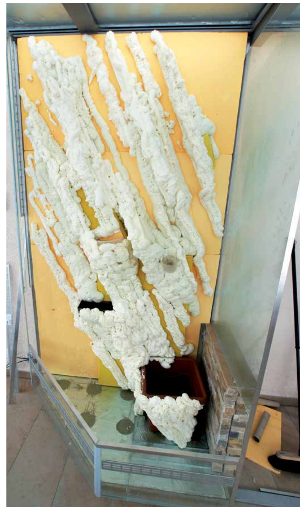
Die Rohform der künstlichen Felswand im fünfeckigen Petrosaurus -Terrarium wurde mit Hilfe von PU-Hartschaumplatten und Montageschaum errichtet. Bereits in dieser Bauphase wurden Töpfe in die Wand integriert, aus denen dann später Pflanztaschen entstanden.
